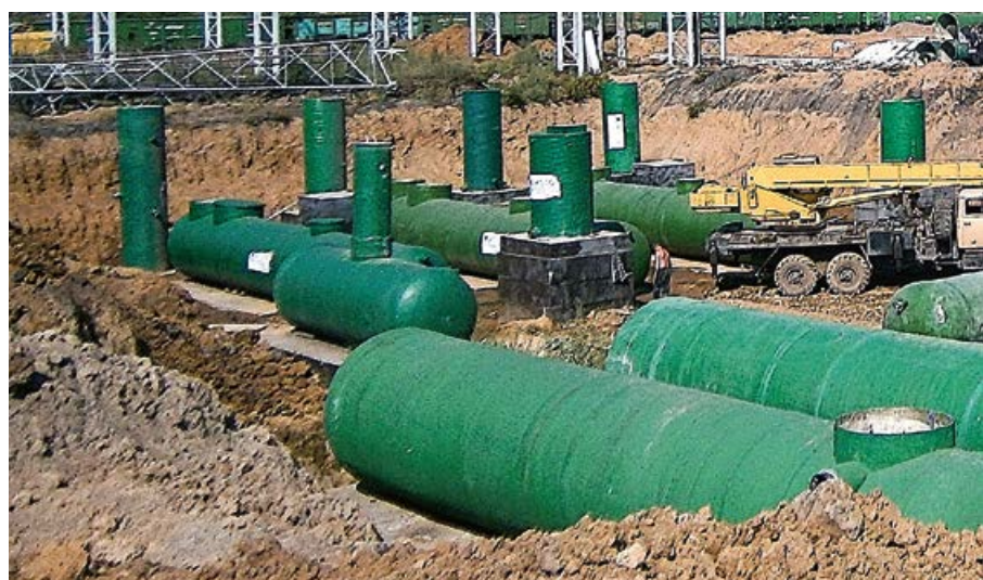
Сорбционный фильтр ЛОС-Ф в системе ливневой канализации. Производительность системы 150 л/с. Томская область, мкрн. Северный, д. Кисловка. 2016 г.
