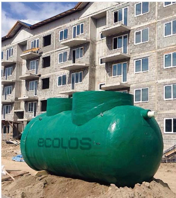
Поставка и монтаж станции ЛОС-БИО производительностью 15 м 3 . с. Ивановское. 2014 г.
