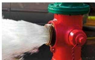
Хранение противопожарного запаса воды
