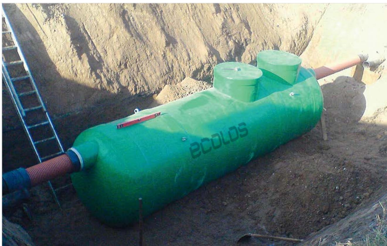
Монтаж станции ЛОС-БИО производительностью 30 м 3 . г. Тюмень. 2015 г.
