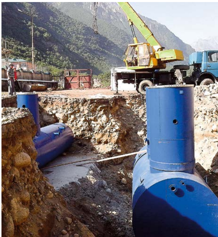
ЛОС-ЕМ объемом 30 м 3 в составе сооружений биологической очистки. Кабардино-Балкарская Республика, г. Нальчик. 2017 г.
