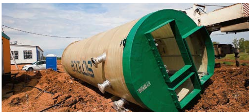
Станция КНС производительностью 300 м³/ч г. Самара, жилой мкр. Волгарь. 2017 г.
