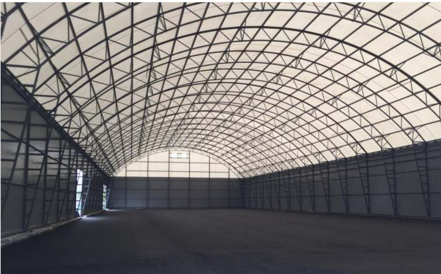
Внутренний вид КТУ/тип исполнения - однослойный
