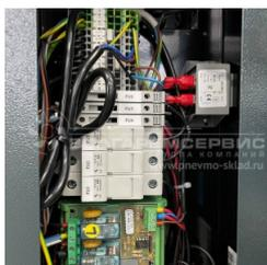
Лучшие в своем классе электрокомпоненты от Siemens. Подходят для работы при повышенных температурах в условиях нестабильного напряжения. Контактные реле, предохранители и другие детали смонтированы в электрошкафу с распашной дверцей. При необходимости ревизии и замены деталей бокс быстро открывается, предоставляя комфортный сервисный доступ. Пространство электрошкафа полностью изолировано от основных рабочих узлов,
