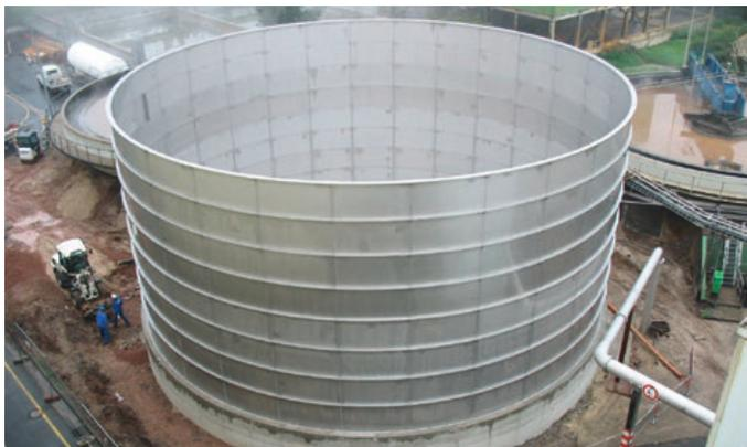
Резервуар для сточных вод 1661 м<sup>3</sup> в бумажном производстве
