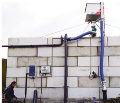
Сепаратор был установлен на бетонный постамент, чтобы обеспечить легкий доступ к сухой фракции (например, для подъезда трактора, погрузчика).
