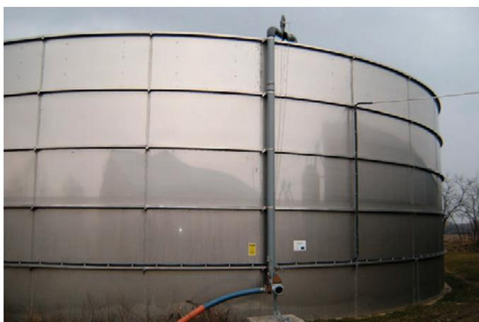
Откачивающая и заполняющая станция с трубой над стенкой резервуара
