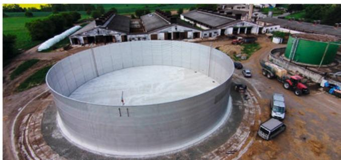
Резервуар из нержавеющей стали с высоты птичьего полёта
