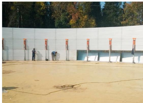
Монтаж с подъёмным устройством
