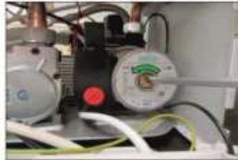
2. Отвинтите центральный винт с помощью отвертки
